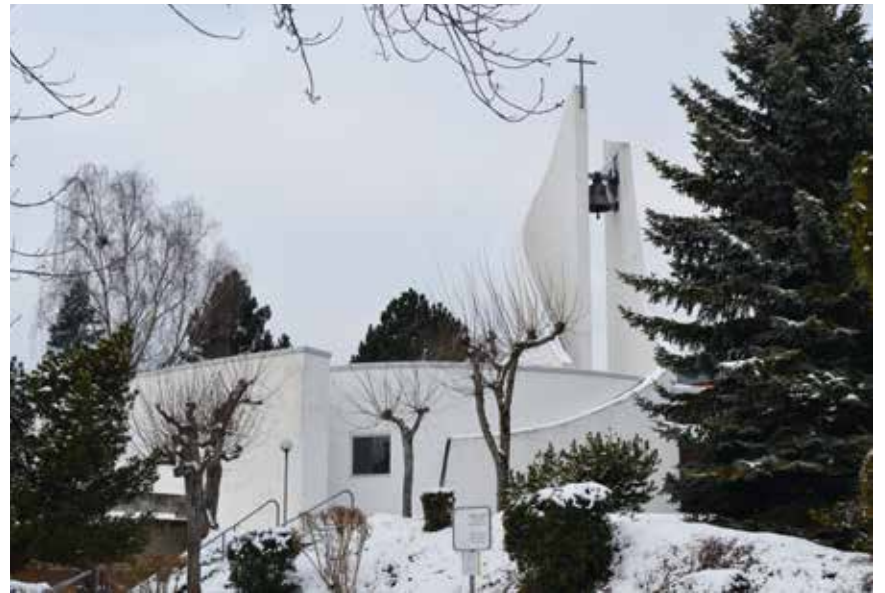
Fermée durant environ deux ans, l'église catholique des Geneveys-sur-Coffrane accueille à nouveau les ouailles depuis le premier dimanche de carême 2017. (cwi)
